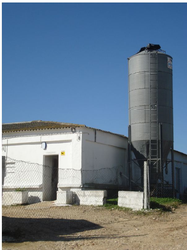
Figura 5 - Silos de armazenamento de ração.
